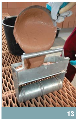
dávkování malty do zásobníku nanáše- čného válce
