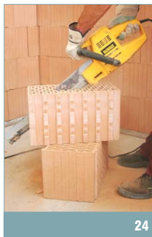
úprava délky cihel na požadovaný rozměr
