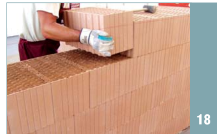
kladení dalších vrstev cihel
