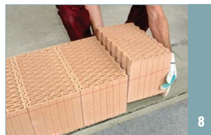
kladení první vrstvy cihel
