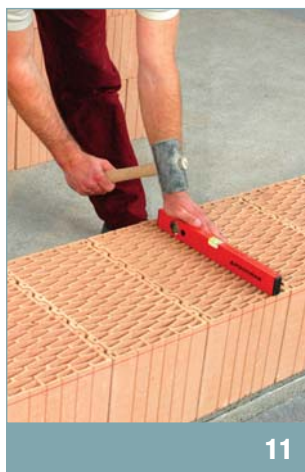
urovnání cihel první vrstvy v příčném směru
