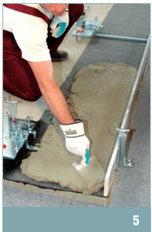
nanášení maltového lože
