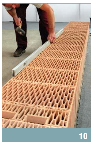
urovnání cihel první vrstvy po délce stěny
