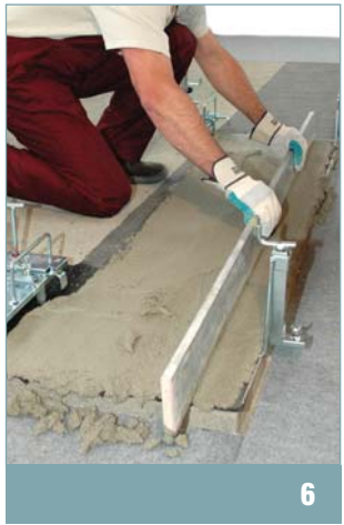
urovnění maltového lože podle vodicích lišt
