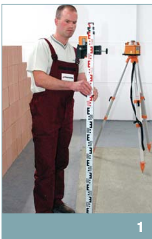
výškové zaměření základové desky
