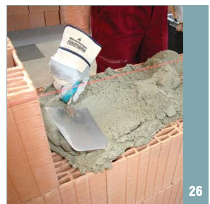
nanesení malty POROTHERM TM na parapet
