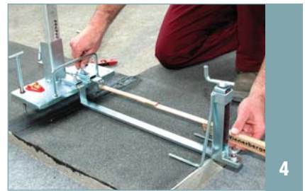
nastavení požadované šířky maltového lože
