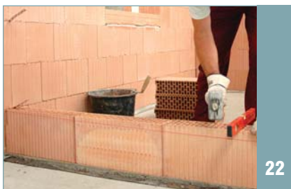
kotvení vnitřní nenosné stěny v každé druhé ložné spáře
