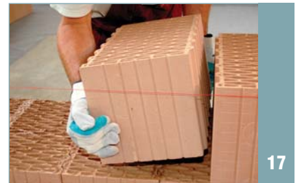
kladení cihel zasunutím do drážek
