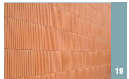
obvodová stěna z broušených cihel
