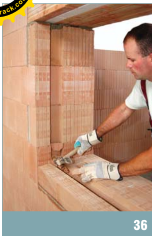
opatrné vyklepnutí přepážek otvorů - kapes
