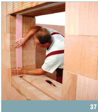
vyplnění otvorů pásy extrudovaného polystyrenu
